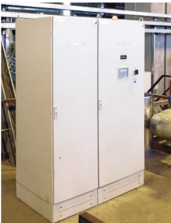
Рис. 2. Внешний вид шкафов с оборудованием ЭЧСРиЗ, установленных на одном из объектов
